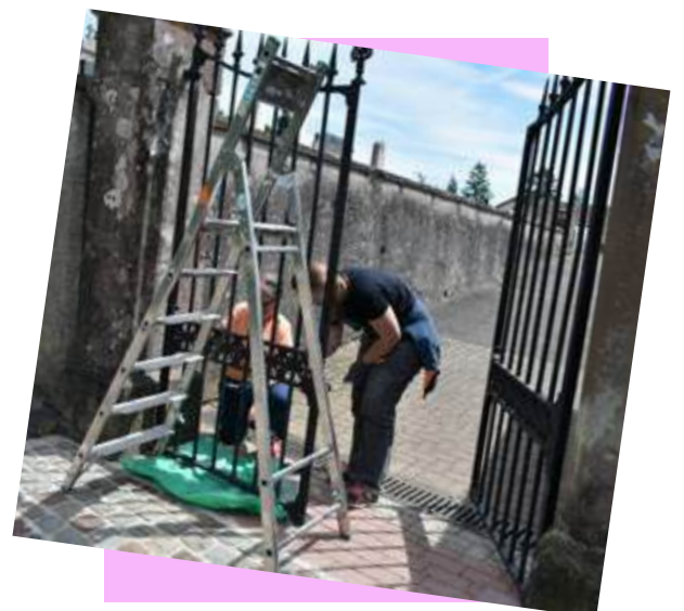
Mise en peinture de la grille principale du cimetière
